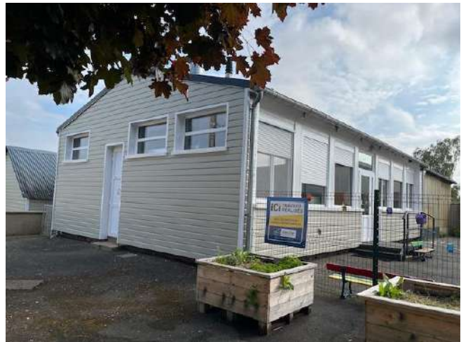
Travaux d'isolation (bardage) et changement des fenêtres
