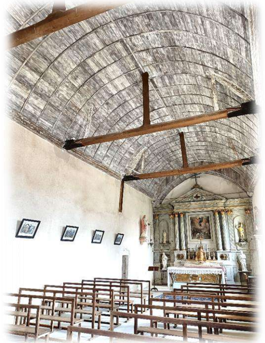
Intérieur de l'église Saint Georges rénové
